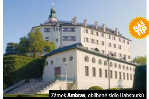
Zámek Ambras, oblíbené sídlo Habsburků
